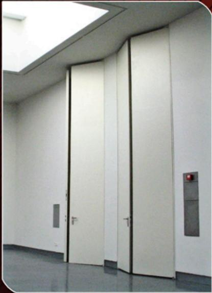
Un innovador sistema "oculto" en el interior de la hoja con punto de giro alto y bajo, sustituye a las tradicionales bisagras, permitiendo mantener los necesarios solapes entre hoja y marco, en una puerta cortafuegos.
